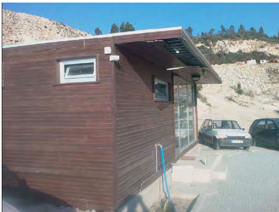
Fotografia 3: Escritório e instalações sanitárias
