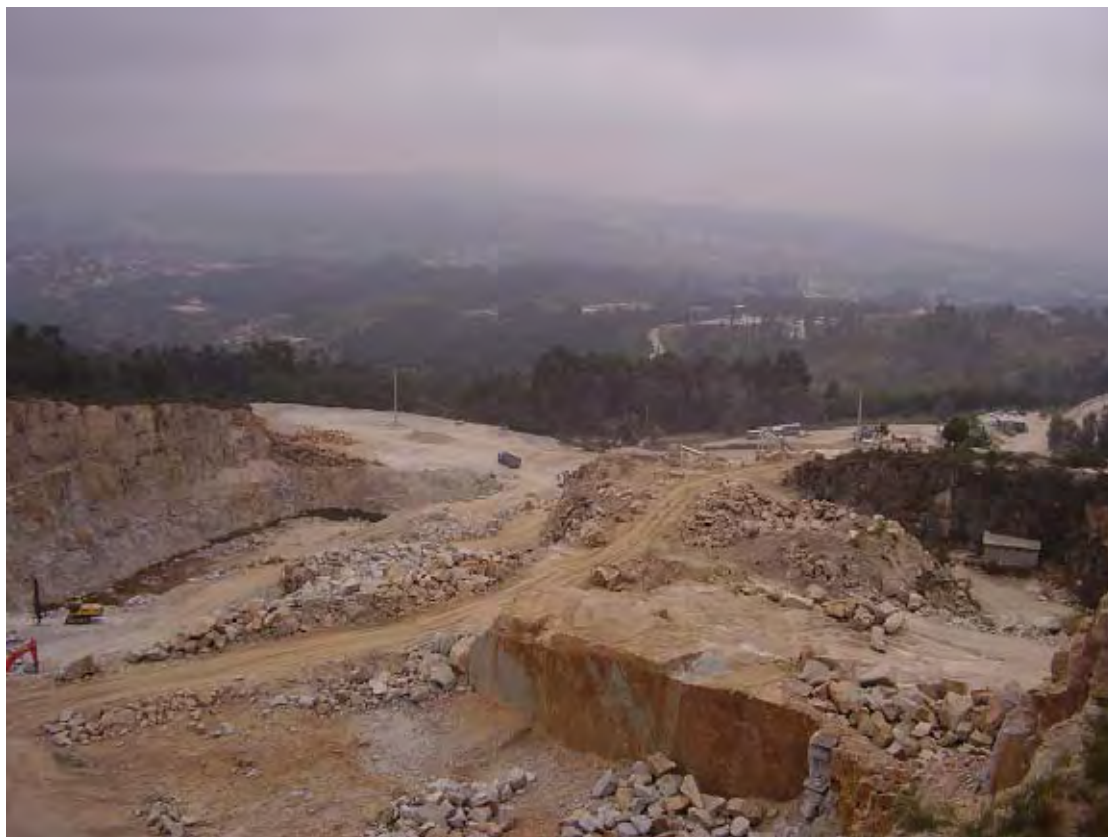
Fotografia 5: Panorama geral da área já explorada com parte das 3 pedreiras já licenciadas. Imagem captada no interior da área a licenciar.
